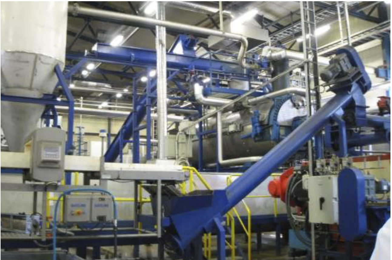
Foto 27. Loomsete kõrvalsaaduste töötlemine Atria Eesti AS-is (tunnustatud teise kategooria loomsete kõrvalsaaduste käitlemiseks).
